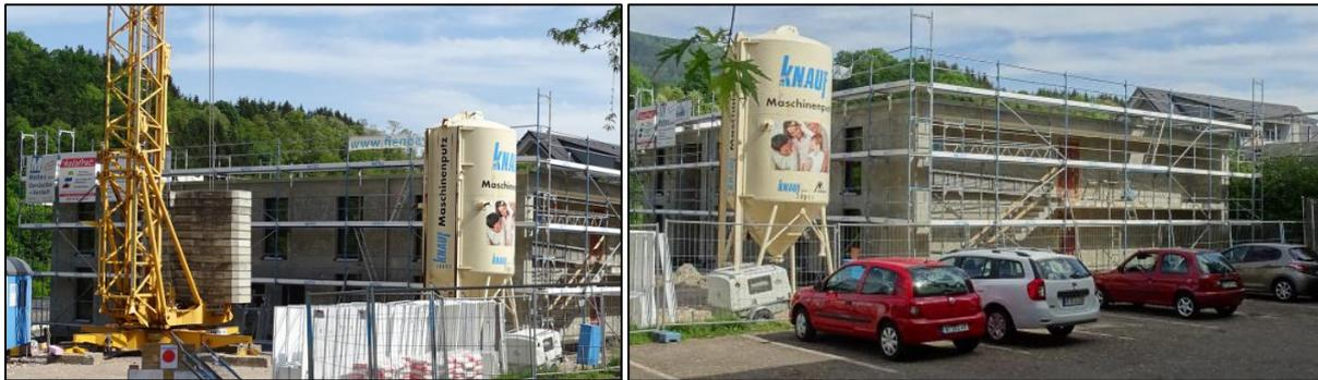
Die Bauarbeiten am Neubau der Obdachlosenunterkunft im Bereich der Öflinger Straße gehen gut voran. Die Rohbauarbeiten konnten aufgrund der milden Witterung über den gesamten Winter 2019/2020 hinweg ohne nennenswerte Unterbrechungen weitergeführt werden. Zwischenzeitlich sind die Maurerarbeiten vollständig abgeschlossen, die Fenster eingebaut und die Arbeiten am Flachdach fertiggestellt. Zahlreiche Ausbaugewerke haben bereits die Arbeiten in dem 2-geschossigen Gebäude in Angriff genommen.
